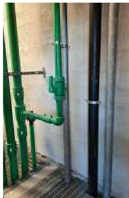
**Acqua di rete e demineralizzata:** Nel cavedio a destra sono collocate le chiusure dell'impianto idrico (impianto acqua di rete ed impianto acqua demineralizzata) di piano.
