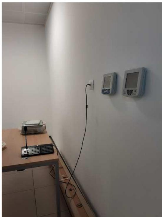
Ai piani in cui è presente la rilevazione gas (2, 3 e 5), all'interno delle "Sale tecnici" (sulla parete entrando a sinistra), sono installati ulteriori rimandi della centrale di rivelazione gas di edificio
