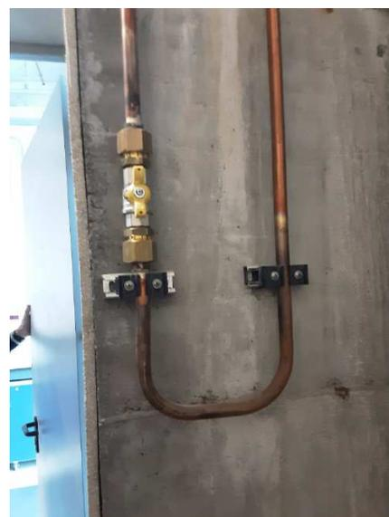
**Chiusura gas metano di edificio:** la saracinesca di chiusura di edificio della rete del gas metano è collocata all'esterno dell'edificio in corrispondenza del montante ai piani. Nello stesso alloggiamento è presente l'elettrovalvola di chiusura collegata all'impianto di rilevazione.
